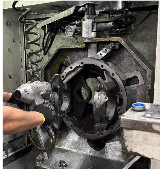
Figura 9: Montaje de tapas de bancada
