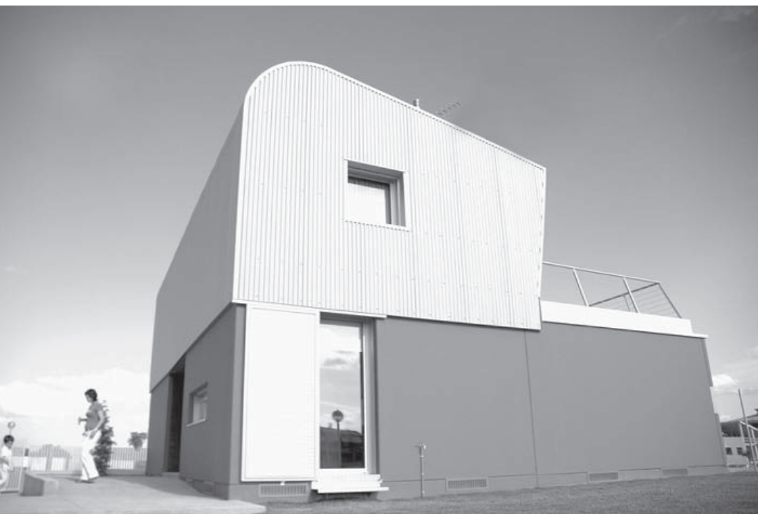
Fig. Nº 19: vista de la casa Kyoto terminada.
