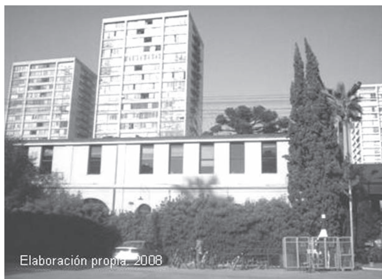
Figs. N° 1a, b y c: vistas del edificio, 2008.
