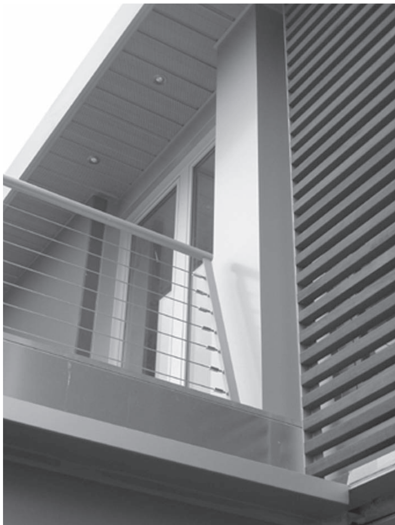
Fig. N° 18: vista de aberturas del primer piso.
