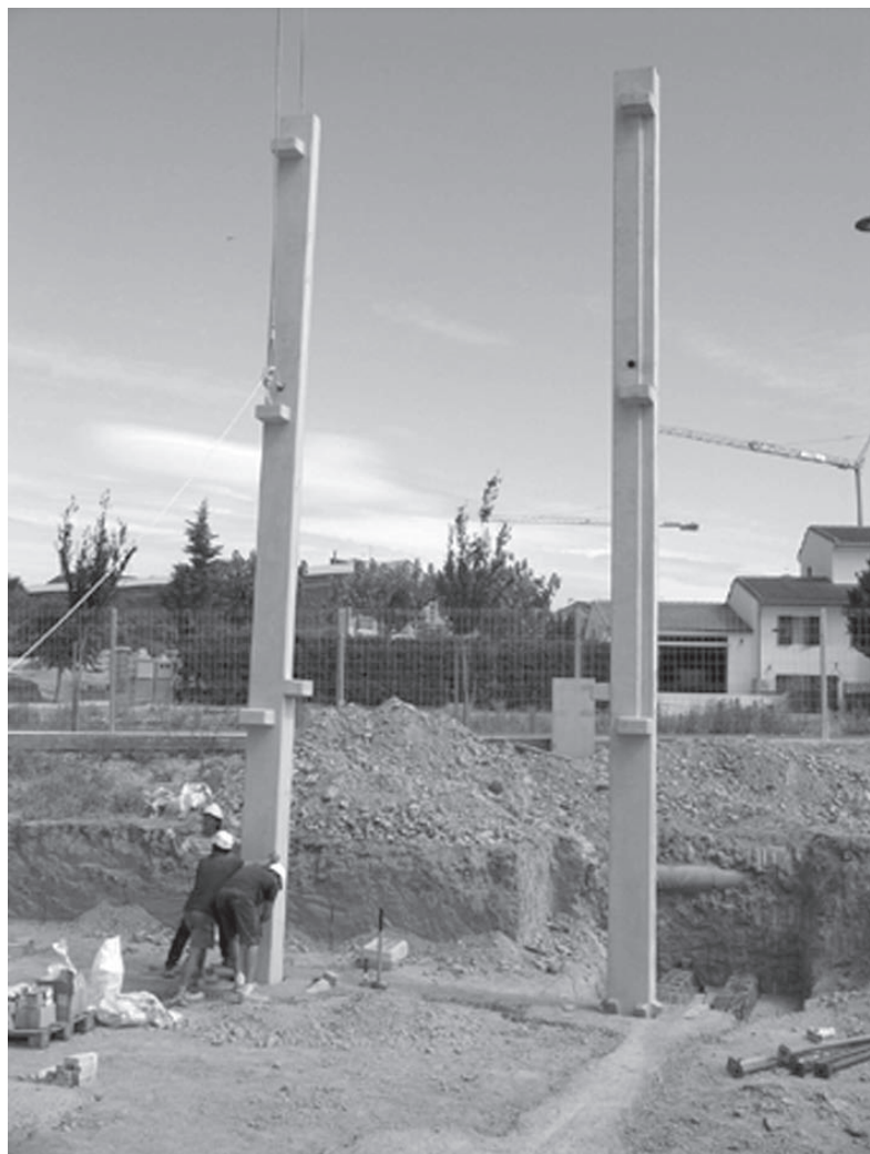
Fig. N° 14: colocación de los primeros pilares de la construcción.
