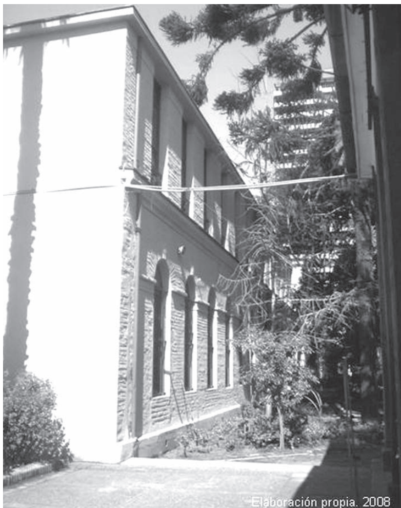
Fig. N° 2: vista lateral del edificio.
