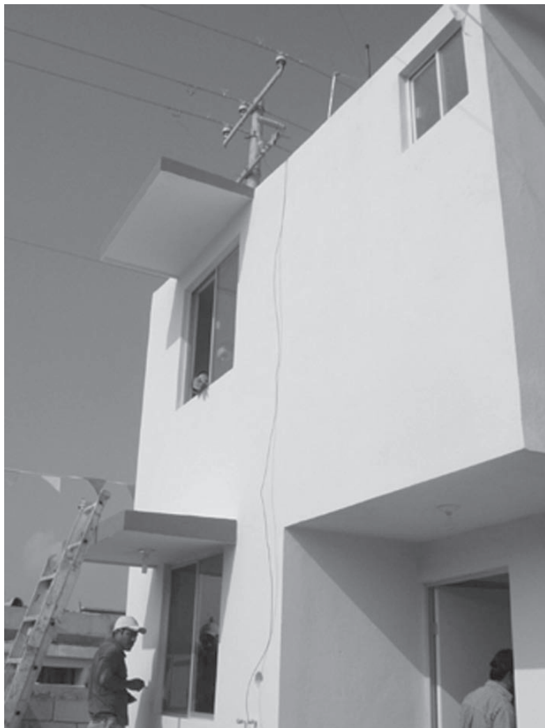
Fig. N° 4, 5, 6 y 7: vistas de las viviendas sustentables en Nuevo León.
