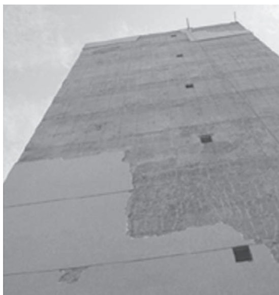
Fig. N° 6d: costado edificio 15 años después.
