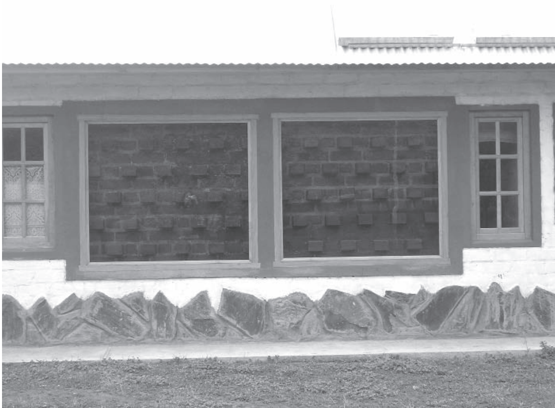
Figs. N° 7, 8 y 9: muros colectores-acumuladores; colectores para calentamiento de agua, cubiertas de la vivienda y del invernáculo; cocina de chapa y termotanque, ambos a leña y de alta eficiencia.
