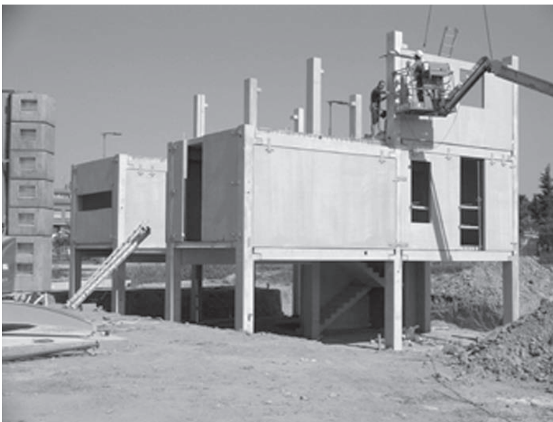
Fig. N° 16: construcción de la casa Kyoto en una etapa bastante avanzada.
