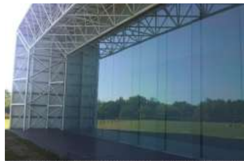
arriostramiento transversal - cordón inferior
