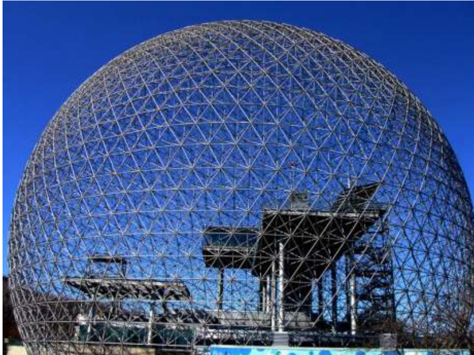
Fig.26: Cúpula de doble malla de 80m de luz y 170m de alto. Buckminster Fuller, Montreal, 1967
