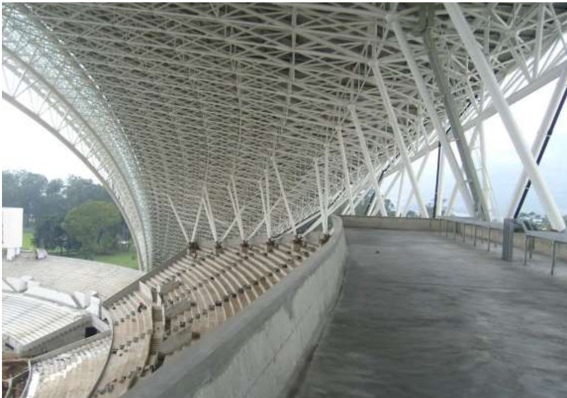
Fig.29: Entramado espacial de doble malla, cubierta de tribuna en el Nuevo Estadio Nacional de Costa Rica
