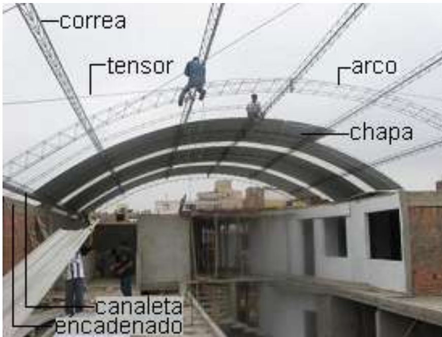
Fig.49: Techo con arcos de filigrana en Tucumán, Argentina.
