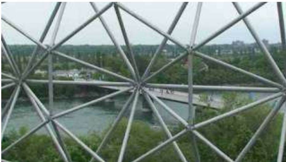
Fig.27: Detalle de la doble malla. Pabellón de Estados Unidos, Exposición Universal de Montreal 1967
