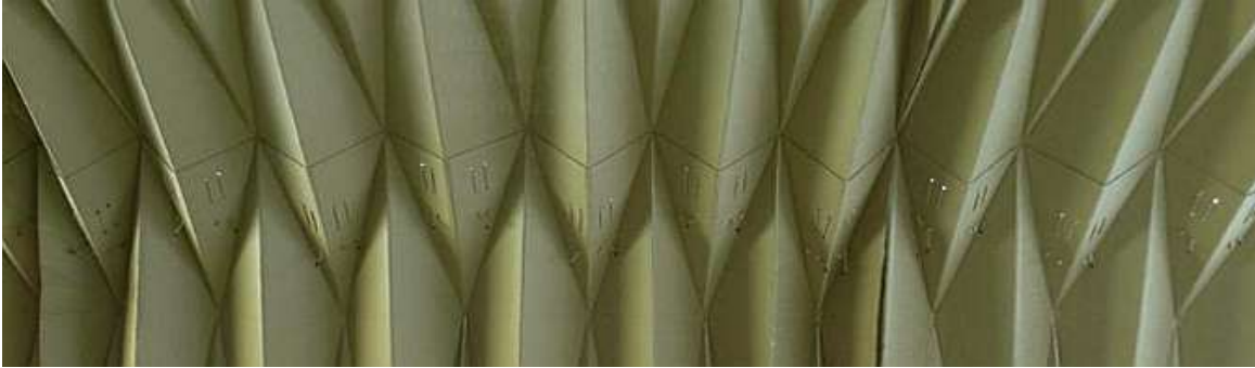
Fig.24: Pórtico plegado (pórtico laminar)
