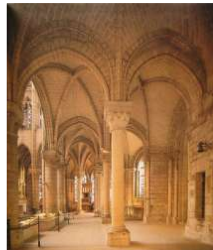
Fig. 32 Estructura del techo bóveda de crucería. Abadía de Saint Denis- 1140-1144 París Francia
