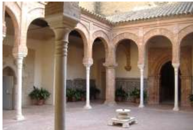
Fig. 10 Arcos Peralzados. Galería de arcos del Claustro del Monasterio de la Cartuja. Sevilla
