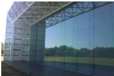
arriostramiento transversal - cordón superior
