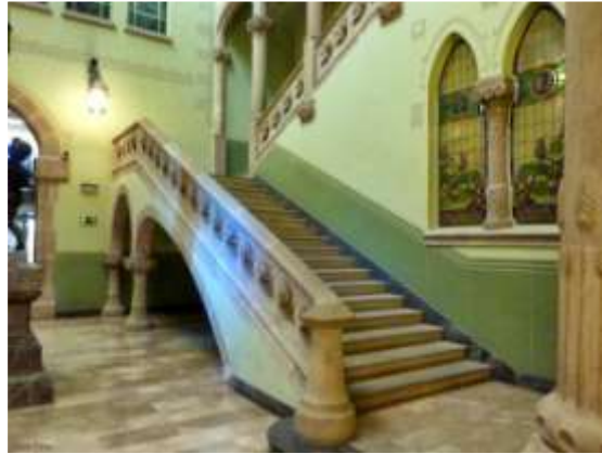
Fig. 13 Arco rampante. Utilizado como estructura de escalera con solicitud interna a la compresión.
