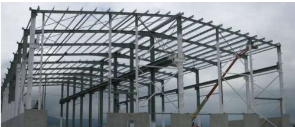
Fig.39: estructura secundaria de correas
