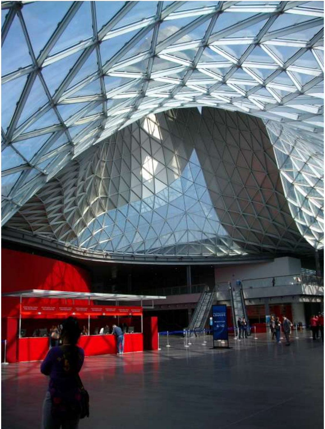
Fig.30: Entramado espacial de simple malla con forma libre. Feria de Milán 2005 en Rho/Pero
