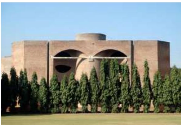
Fig.21: tensores de hormigón armado en el Institute for Management, Ahmedabad, India, Louis Kahn, 1962
