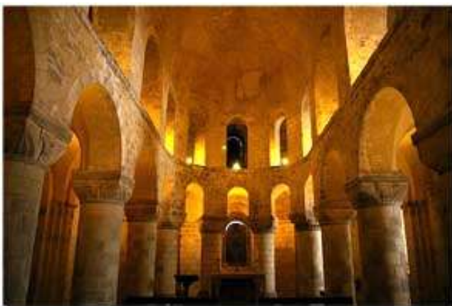
Fig. 31 Estructura del techo bóveda de cañón corrido. Capilla de Saint John- 1078- White Tower-Londres.
