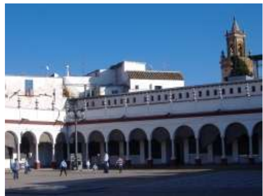
Fig. 08 Arcos de medio punto en el Mercado de Abasto Carmona.
