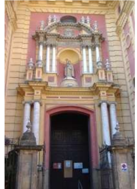
Fig. 12 Arco escarzano, otra variante del arco rebajado. Iglesia de San Ildelfonso. 1794-1841
