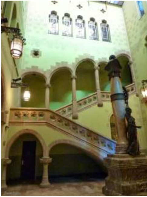
Fig. 13 Arco rampante. Utilizado como estructura de escalera con solicitud interna a la compresión.
