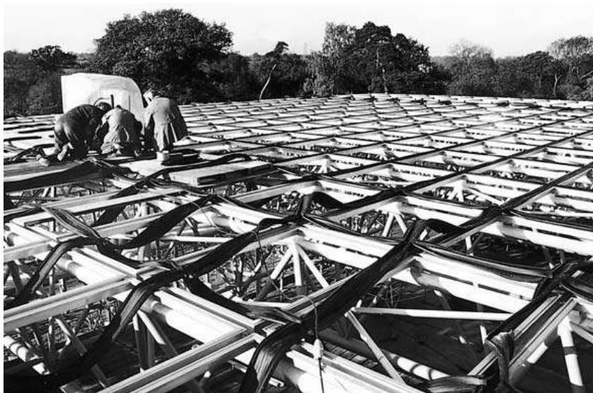
Fig.42: montaje de paneles de techo en Sainsbury Center
