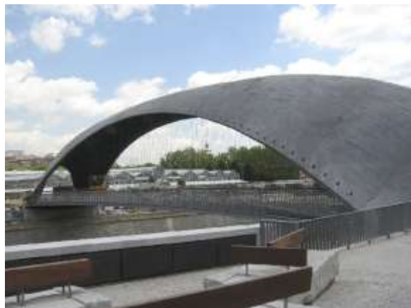
Fig.22: Cáscara de doble curvatura sinclástica sobre el Río Manzanares, Madrid: doble curvatura positiva.
