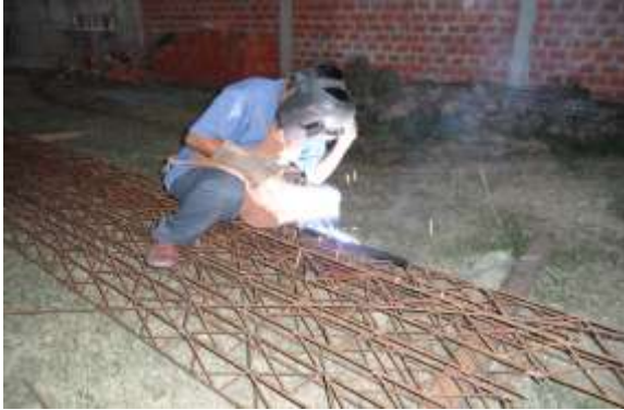
Fig.47: Correas de acero redondo doblado y soldado
