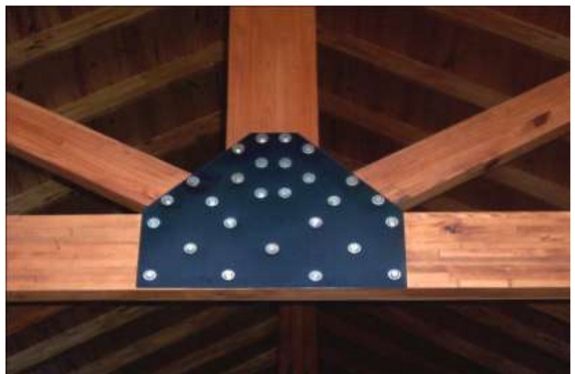
Fig.17: Unión con pernos o bulones
