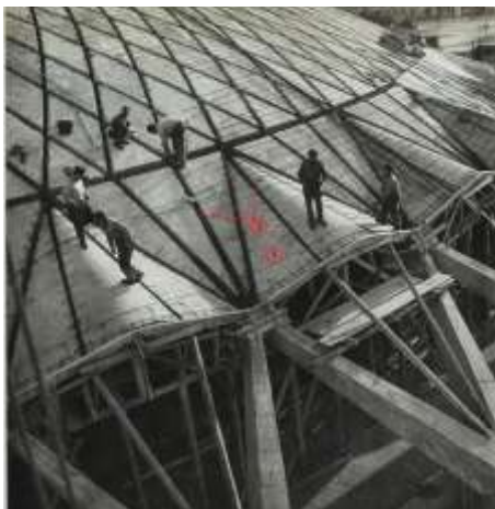
Fig.21: Técnica del "ferrocemento" en el Palazetto dello Sport.
