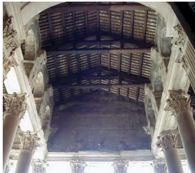
Fig. 03: Panteón de Agripa, parte central del Pronaos, La estructura del techo (central y laterales) originalmente era de bronce con perfiles en “U”. Posteriormente se reemplazaron por madera.
