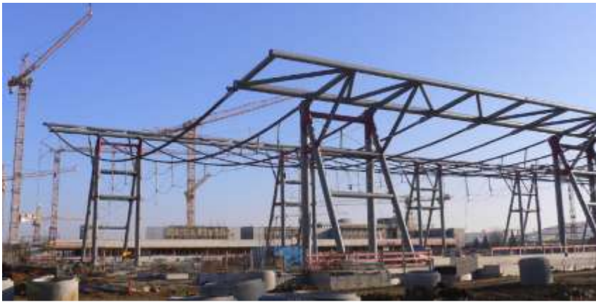
Fig.30: etapa constructiva, antes que se monten los contracables estabilizadores
