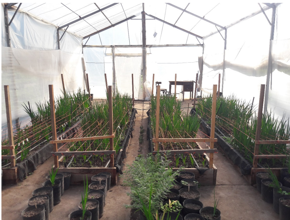
Foto 1: Invernadero tipo capilla con cubierta de polietileno (larga duración térmica).
