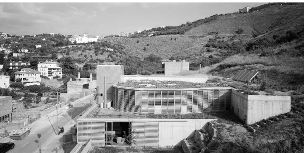
Vista completa, donde se pueden observar los paneles solares
