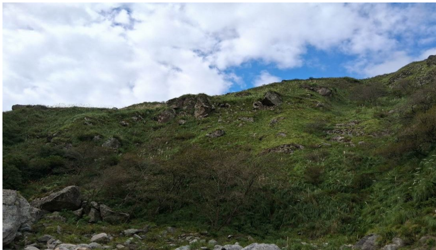
Foto V.5: Bloques de basamento en inestabilidad en margen derecha del río de Las Cañas.
