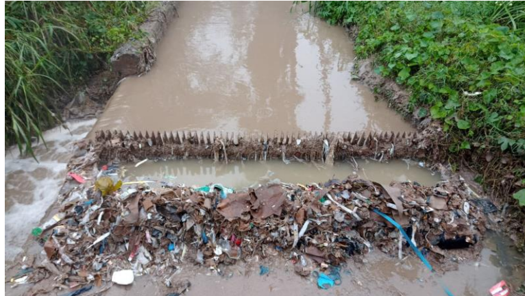
Figura 3.27: Taponamiento de reja gruesa de entrada
