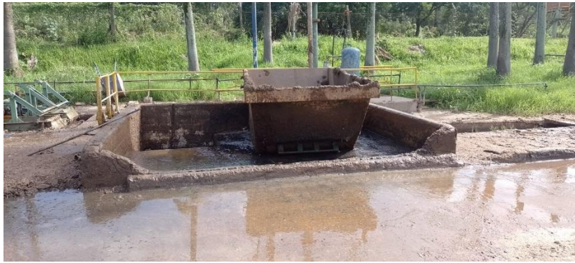
Figura 3.31: Dispersión lateral del material expulsado del desarenador en las periferias del contenedor
