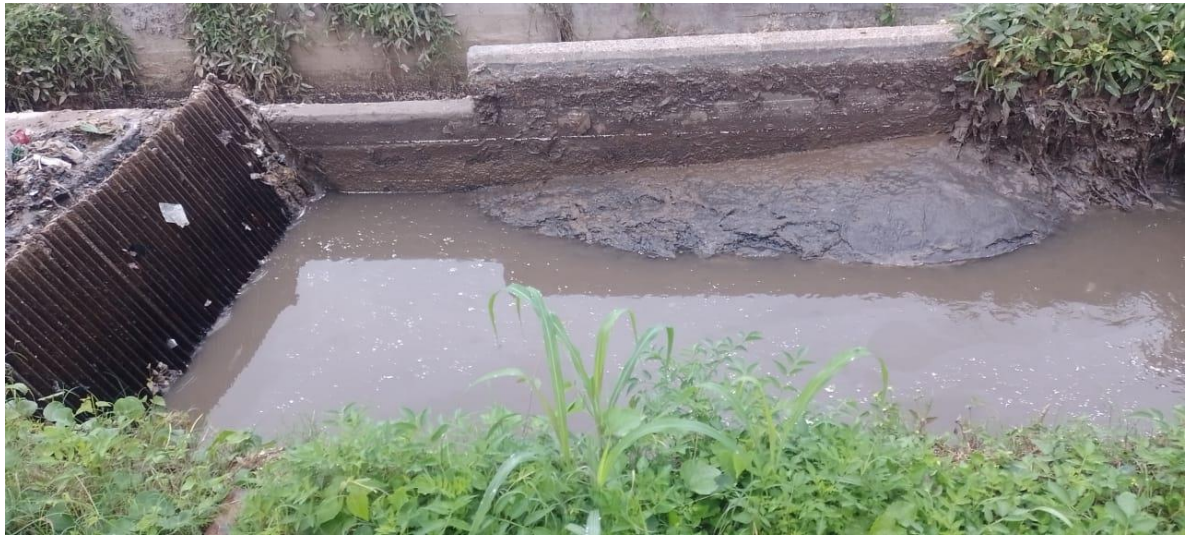
Figura 3.30: Deposición de arena en canal de entrada a PTE
