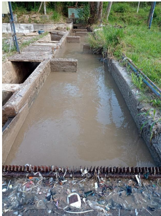
Figura 3.18: Canal de entrada a PTE y primera reja gruesa manual
