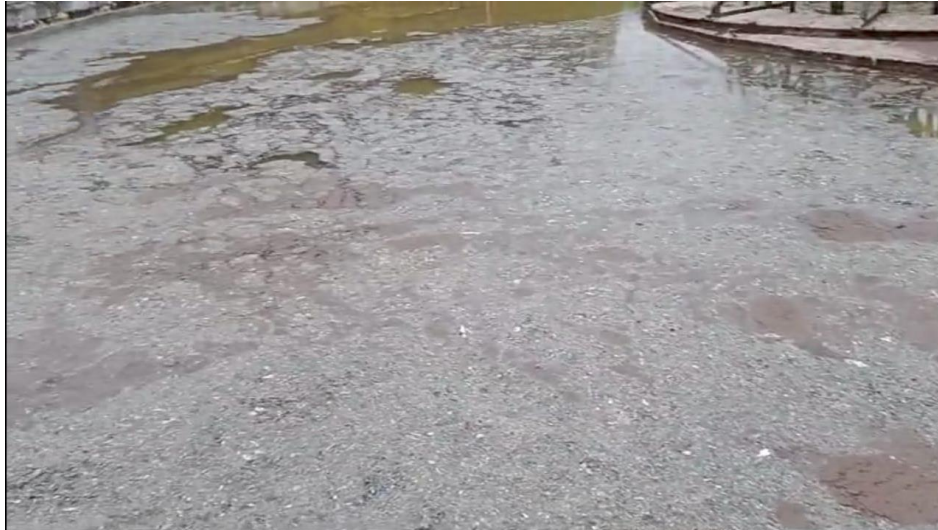
Figura 3.33: Nivel de clarificador casi al máximo de barros
