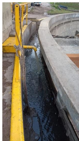
Figura 3.25: Recolección de líquido sobrenadante de clarificador por rebalse
