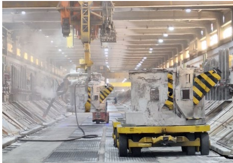
Figura 1.12 Operación de Colada. Se pueden observar las cucharas. Fuente: Planta de Producción de Aluminio.
