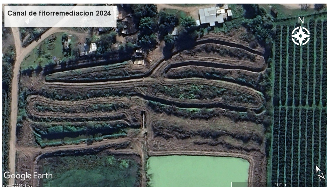
Figura 12: Imagen satelital del canal de fitorremediación, que posee en total 1000 m de longitud, las profundidades varían, en el este están las profundidades más grandes, la parte somera se ubica en el oeste
