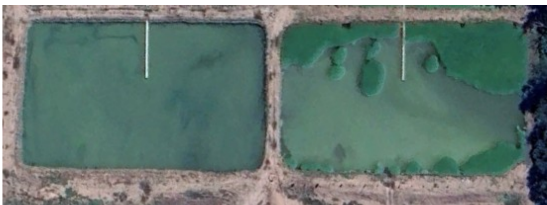
Figura 6: Imagen satelital de las lagunas anaeróbicas de la PTAR- La Bolsa, de Google earth, 03/03/2025
